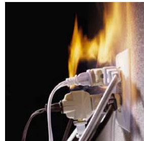
Riesgo de incendio por sobrecarga de conexión
